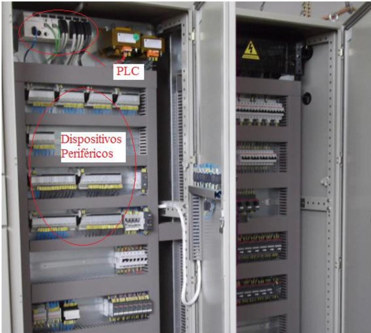
FIGURA 10 - Implementação de *hardware* utilizando PLC
