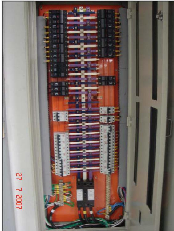
**Figura 12:** Parte interna quadro de distribuição elétrica
