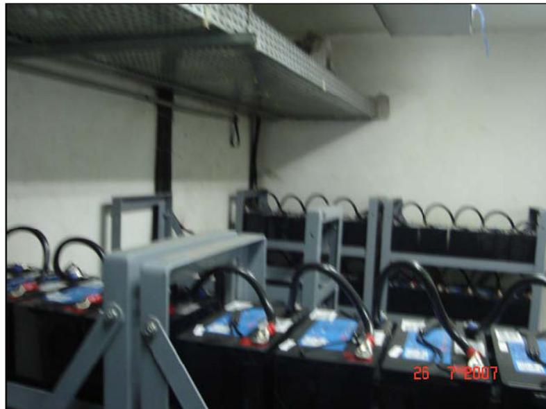
**Figura 10:** Instalação de baterias
