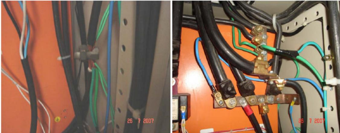
**Figuras 15 e 16:** Conectorização sujeita a falhas
