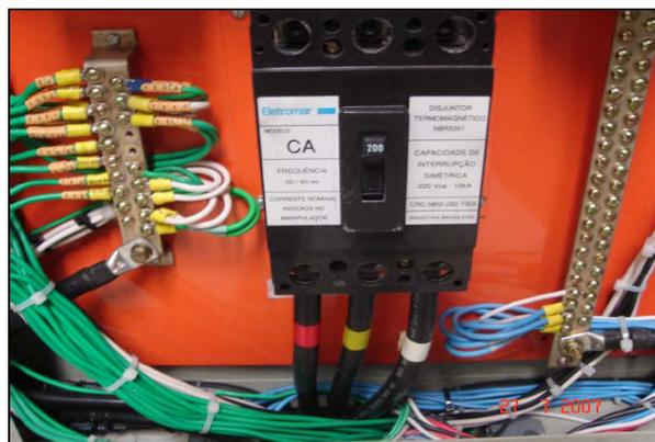
**Figura 13:** Disjuntor geral e barramentos de distribuição
