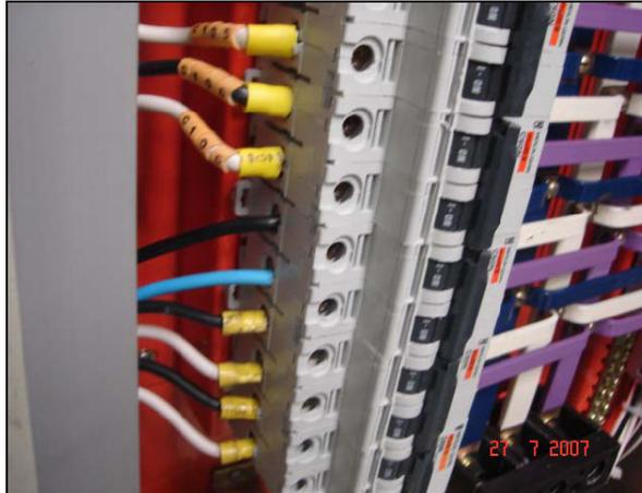
**Figura 14:** Conectorização de disjuntores
